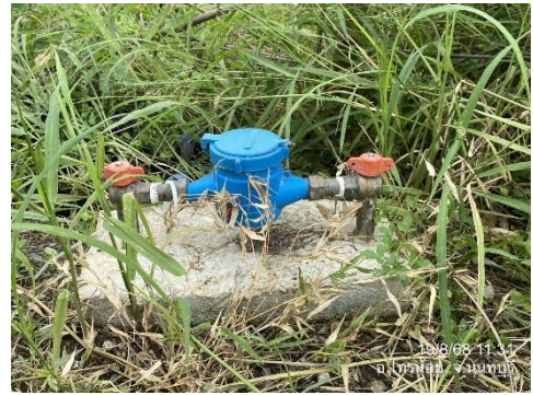
(11) จุดเชื่อมต่อน้ำประปาจากการประปานครหลวง - พื้นที่ก่อสร้างโครงการ
