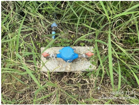
(11) จุดเชื่อมต่อน้ำประปาจากการประปานครหลวง - พื้นที่ก่อสร้างโครงการ
